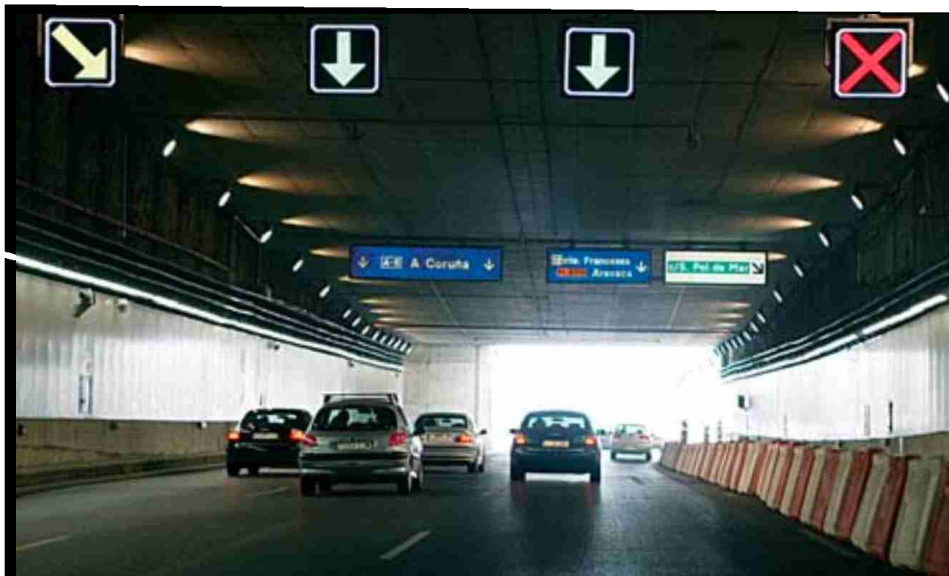
Aspecto interior del túnel entre el nudo sur y el Paseo del Marqués de Monistrol. MARTÍN BILBAO
